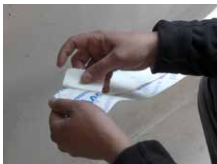
10. Ściągnąć krótki kawałek przekładki z jednej strony i położyć odsoniętą taśmę klejącą na paroizolacji. Usunąć resztę przekładki ochronnej, dociskając mocno taśmę klejącą.
