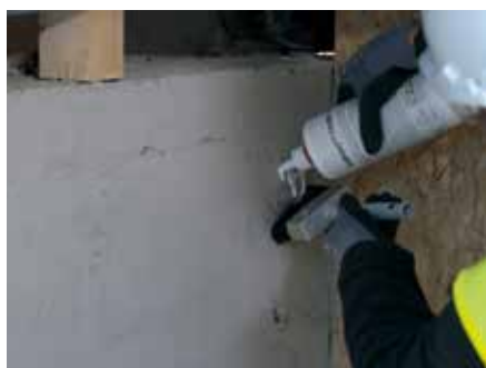
4. Zastosować Tyvek® Primer, aby ustabilizować powierzchnię i poprawić przyczepność przed przyklejeniem taśmy klejącej.
