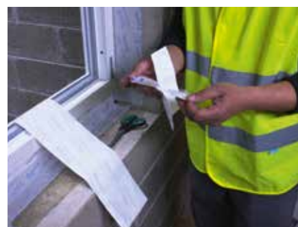
6. Usunąć ćwiartkę paska zabezpieczającego i ...
