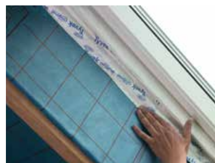
7. ...i docisnąć ją. Starać się, aby pasmo było nałożone gładko. W tym celu należy unikać załamania i fałd. Powtórzyć tę operację z drugiej strony okna.
