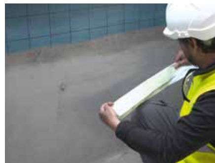
9. Zastosować taśmę klejącą Tyvek® Plastering Tape 150 mm, można złożyć taśmę wzdłuż podziału przekładki zabezpieczającej.
