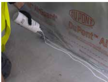
2. Nałożyć preparat gruntujący Tyvek® Primer w celu przygotowania powierzchni i uzyskania lepszej przyczepności.
