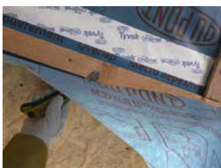
3. ... i krawędzią górnego ościeża okiennego.
