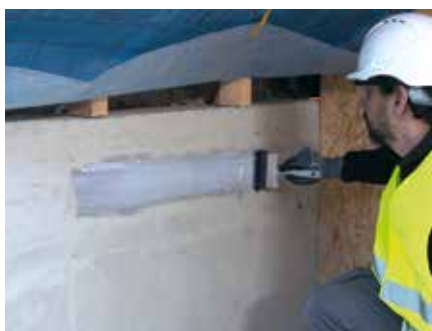
5. Nałożyć grunt Tyvek® Primer o grubości 1 mm na powierzchnię.
