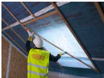
1. Za pomocą drewnianej taty wyciąć „Y” w pasmie izolacji.
