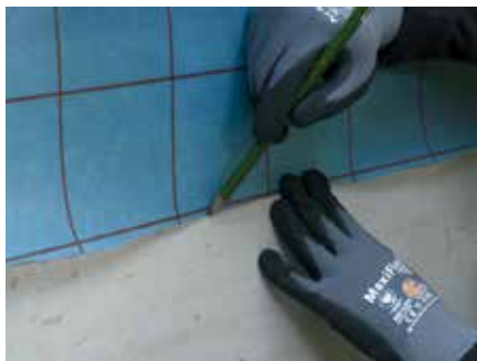
2. Zaznaczyć miejsce, w którym ma być nałożony preparat gruntujący Tyvek® Primer.
