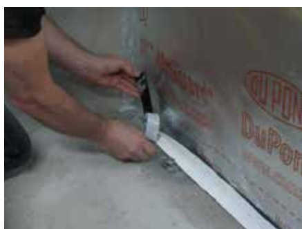
7. Ściągnąć spodnią folię zabezpieczającą od strony ściany i przykleić taśmą w żądanej pozycji. Usunąć resztę folii oddzielającej i od razu docisnąć taśmę klejącą do pasma na ścianie.
