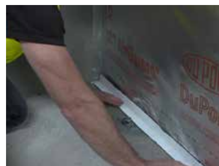
6. Umieścić Tyvek® FlexWrap EZ w rogu między ścianą a posadzką.
