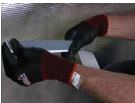
5. Złożyć taśmę klejącą wzdłuż środka na całej długości.
