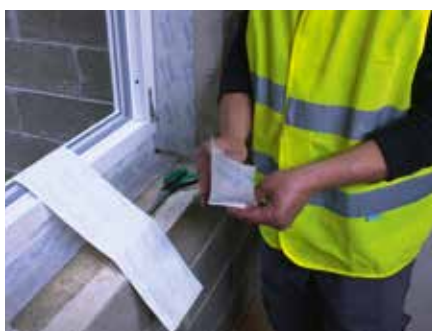
5. Rozłożyć tak, aby uzyskać trójwymiarowe naroże.
