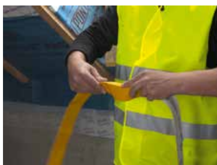
5. Zastosować taśmę klejącą Tyvek® 60 mm z dzieloną folią zabezpieczającą, złożyć najpierw taśmę wzdłuż na podziale i ściągnąć wąską część folii zabezpieczającej.
