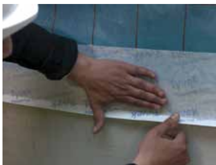
11. Usunąć drugą część zabezpieczającej folii ochronnej. Rozłożyć na zagruntowaną powierzchnię i całość docisnąć.
