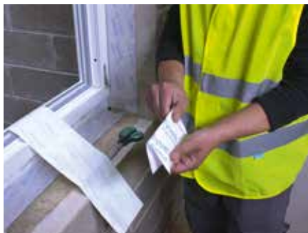
2. Wewnętrzne naroża można zakleić dodatkowym kawałkiem taśmy Tyvek® Plastering Tape. Uciąć najpierw kwadratowy kawałek taśmy i złożyć go na środku.
