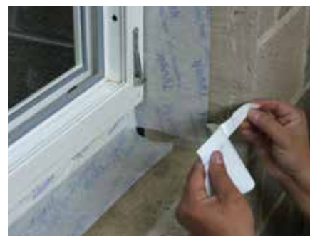
9. Usunąć folię zabezpieczającą.
