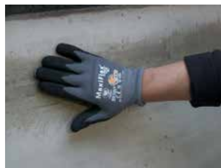
6. Po upływie ok. jednej godziny powierzchnia stanie się przezroczysta i gotowa do klejenia.
