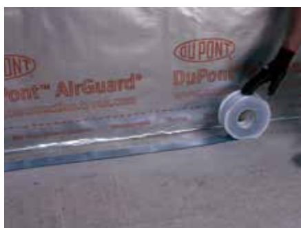
4. Zmierzyć i uciąć wymaganą długość elastycznej taśmy Tyvek® FlexWrap EZ.
