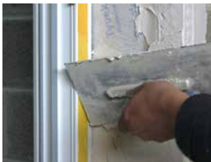
11. Taśma klejąca Tyvek® Plastering Tape tworzy odpowiednie podłoże do nakładania gipsu lub tynku.
