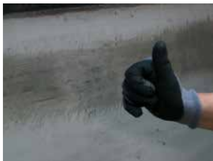
7. Następnie do zagruntowanej powierzchni można przyłożyć paroizolację DuPont™ AirGuard®
